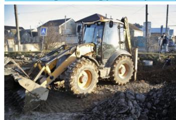
Протяженность реконструируемого участка составляет 900 м. На сегодняшний день здесь полностью завершена укладка инженерных сетей, продолжается процесс подключения частных домов к инженерным коммуникациям. С жителями улицы проводится разъяснительная работа о том, что они сами должны до укладки асфальтового полотна и пешеходного тротуара подключить свои дома к центральным сетям.
